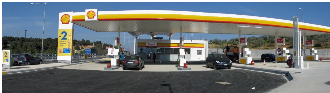
Δ4. Μελέτη εφαρμογής, τεύχη δημοπράτησης και επίβλεψη αρχιτεκτονικών του πρατηρίου της εταιρείας ΕΚΟ στο ΣΕΑ Σπαθοβουνίου (υλοποιημένο)
